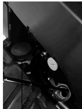
副水箱注入口
